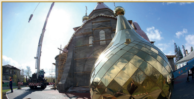
Установка центрального купола. Май 2013 года
